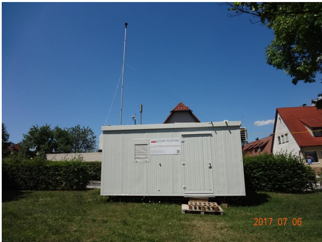
Abbildung 4: Messstelle S245 in westliche Richtung (Aufnahmedatum: 6.7.2017)
